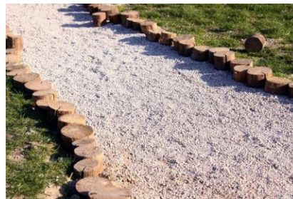
Рис. 9. Отсев или песчано-гравийное покрытие
