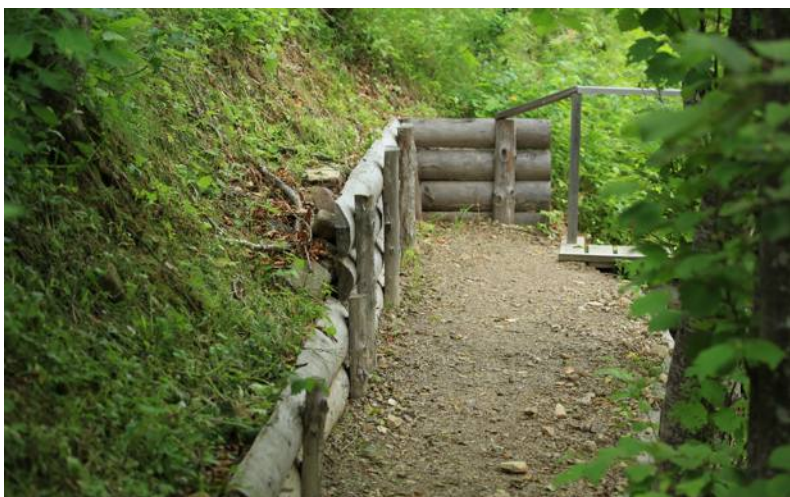
Рис. 56. Подпорная стенка позволяет укрепить склон и предотвратить осыпь. Материал: лиственница
