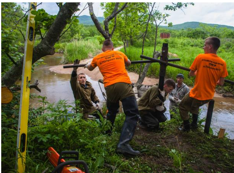
Рис. 51. Установка опор будущего моста
