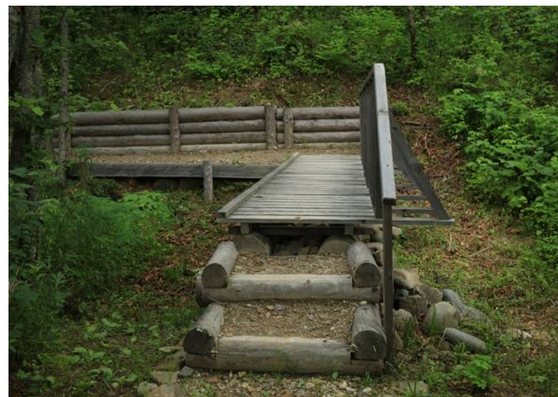
Рис. 54. К мосту ведут насыпные ступени с каркасом из специально обтёсанных брёвен – технология, описанная в книге Боба Биркби «Тропа, парящая над землей» [16]
